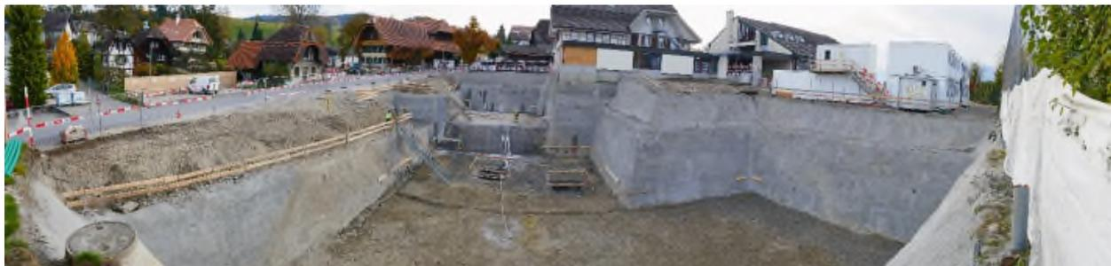
Die fertige Baugrube am 22. Okt. 2020 mit den Öffnungen für Lift- und Pumpenschacht.
