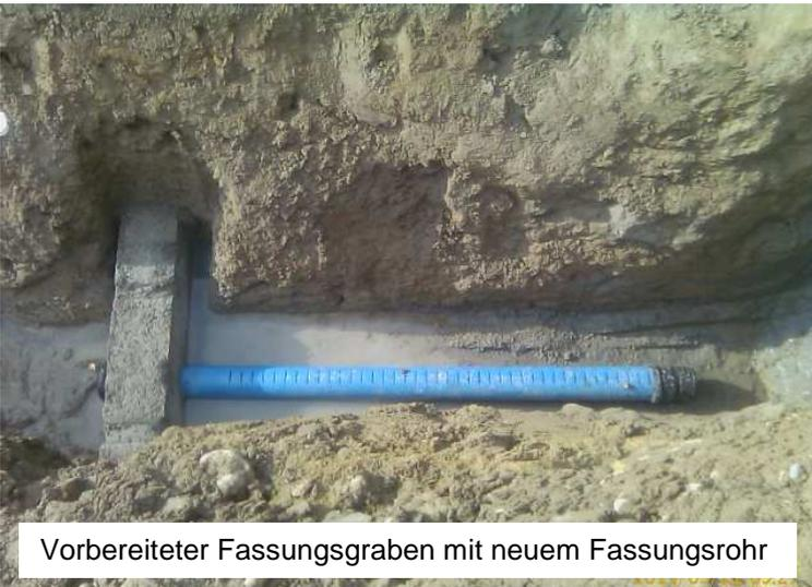
Vorbereiteter Fassungsgraben mit neuem Fassungsrohr
