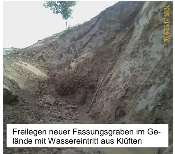
Freilegen neuer Fassungsgraben im Gelände mit Wassereintritt aus Klüften
