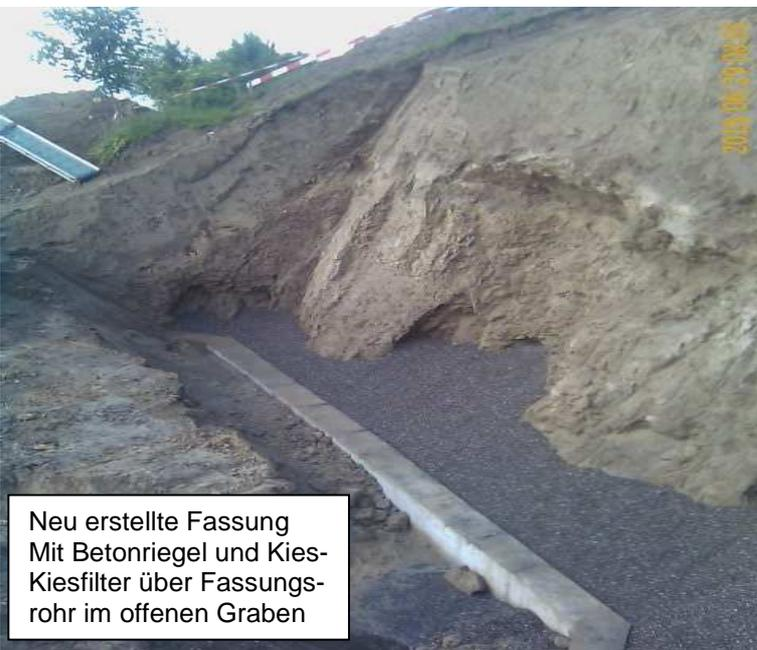
Neu erstellte Fassung Mit Betonriegel und Kies-Kiesfilter über Fassungsrohr im offenen Graben
